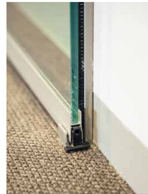
01 DETAIL BODENDICHTUNG, WANDPROFIL MIT DICHTUNG
