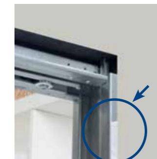
02 KLETTBAND AUFKLEBEN DES KLETTBANDES AUF DAS SCHIENENTRAGSYSTEM
