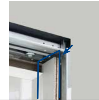
05 MONTAGE ANSCHLAGPLATTE (FUTTER) EINSCHIEBEN DER ANSCHLAGPLATTE IN DIE BEKLEIDUNG
