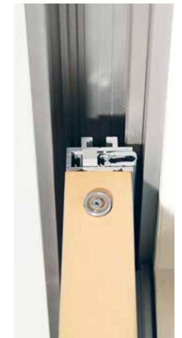
03 DETAIL OBERE DICHTUNG
