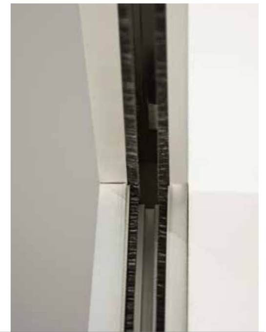
02 DETAIL DICHTUNG EINLAUFPROFIL
