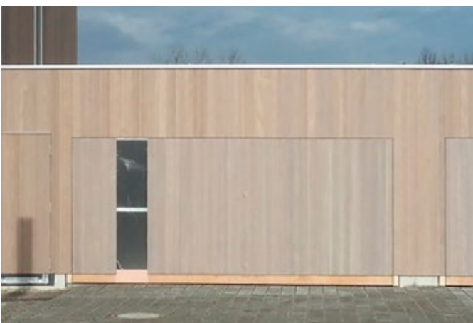
Garagentor zwei Monate später eingesetzt
